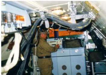
Automatizované kontrolní zařízení TAKT-51
