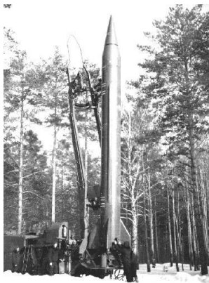
Sklápění kolébky do horizontální polohy
