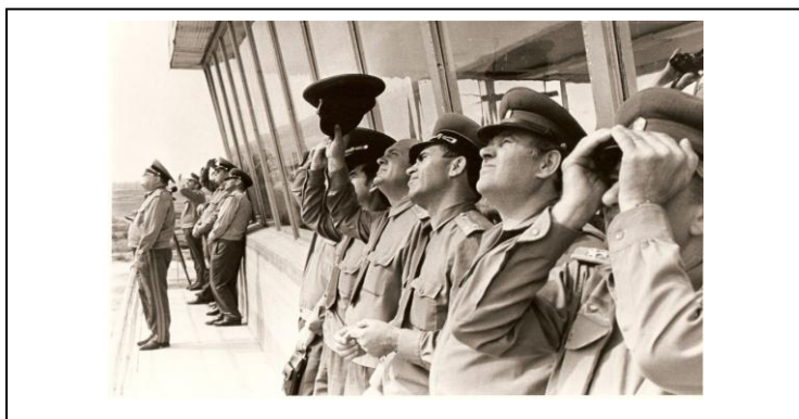
Střelby 321.tdb, srpen 1978, na pozorovací věži při odpálení rakety
