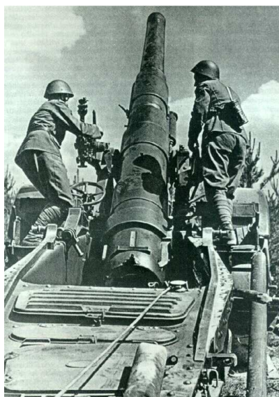
15 cm těžký kanón vz. 15 dostřel 17.500 m(?), střela 56 kg (převzat do čs. výzbroje)
