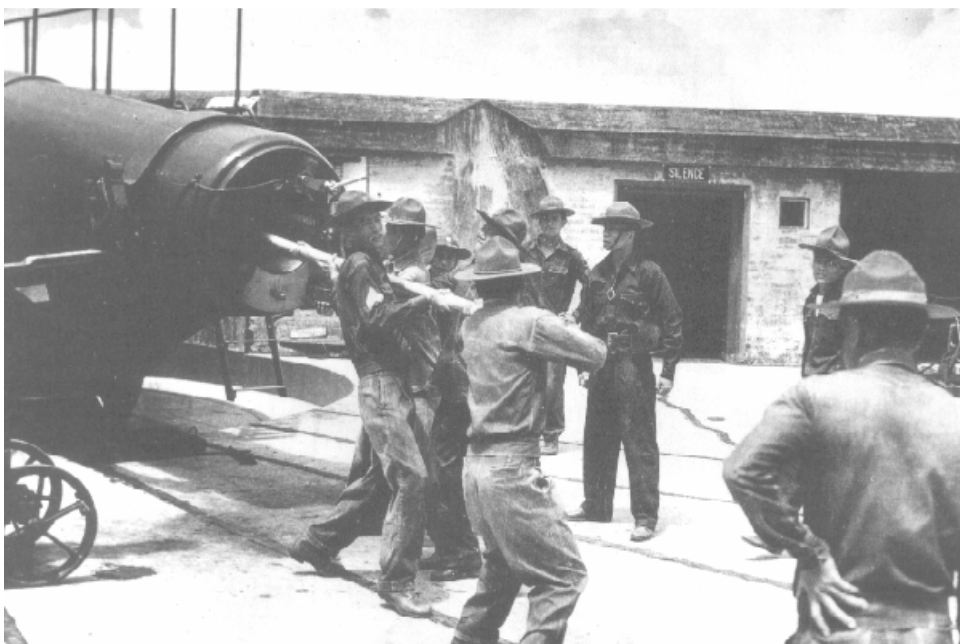
Desetitunový moždíř v americké pevnosti Corregidor na Filipínách, 1000 liberní granát, rychlost střelby 2 výstřely / min
